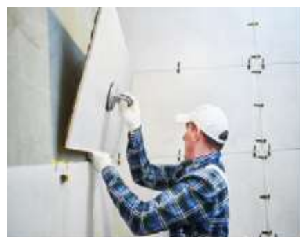
Figura 29. Montarea plăcilor de dimensiuni mari
