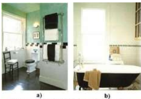
Figura 19. Executarea frizelor din plăci de culoare diferită: a) plăci de aceeași dimensiuni, dar culoare diferită; b) plăci montate în formă de romb.
