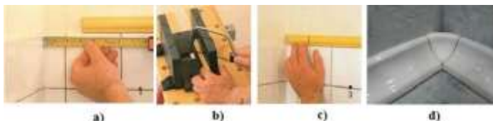
Figura 18. Montarea frizelor și plintelor: a) măsurarea și însemnarea dimensiunii frizei; b) tăierea în unghi; c) montarea frizei tăiate; d) montarea plintei.
