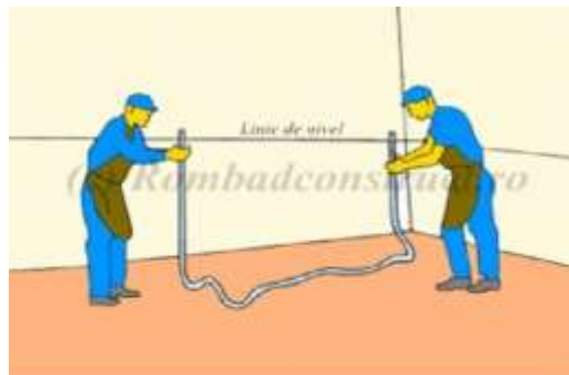
Figura 12.1 Trasarea cu furtunul de nivel
