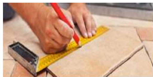
Figura 3. Însemnarea plăcilor cu creionul și colțar de 90°.
