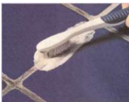
Figura 5. a) Curățarea mucegaiului pe suprafața chitului dintre rosturi; b) Aplicarea sigilantului.
