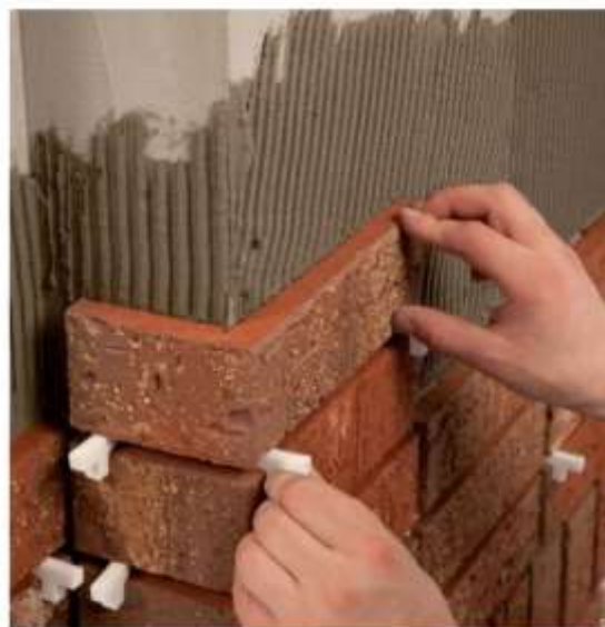
Figura 33. Montarea plăcilor de colț
