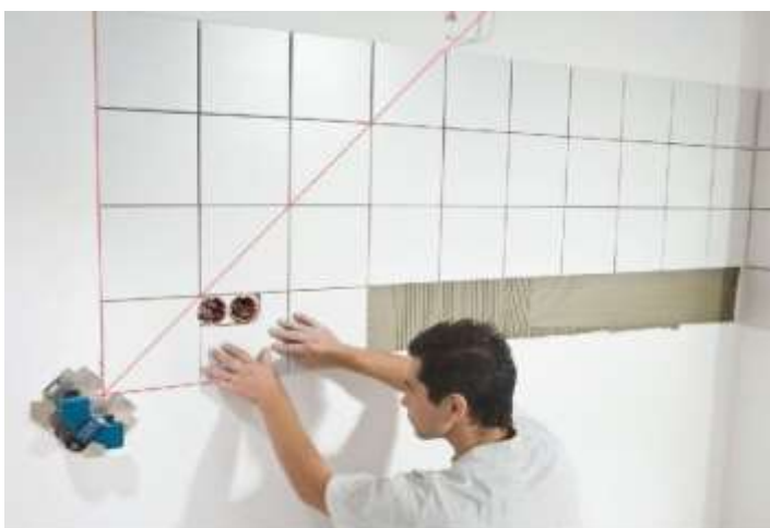
Figura 12. Verificarea montării plăcilor cu nivela cu laser.
