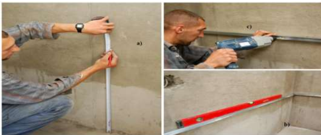
Figura 11. Trasarea suprafețelor verticale pentru realizarea placajului: a) însemnarea înălțimei rândului întâi de plăci; b) verificarea orizontalității dreptarului cu ajutorul nivelei cu bulă; c) fixarea dreptarului de ghidare pe suprafață.
