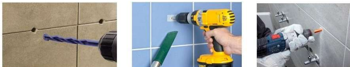
Figura 9. Executarea găurilor cu burghiul
