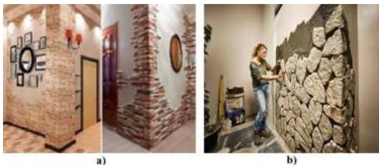
Figura 30. Realizarea placării cu plăci 3D (în relief) : a) Montarea plăcilor 3d fără rosturi; b) Montarea plăcilor 3d cu rosturi.
